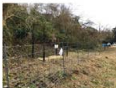
△平成30年度に設置した鉄柵
