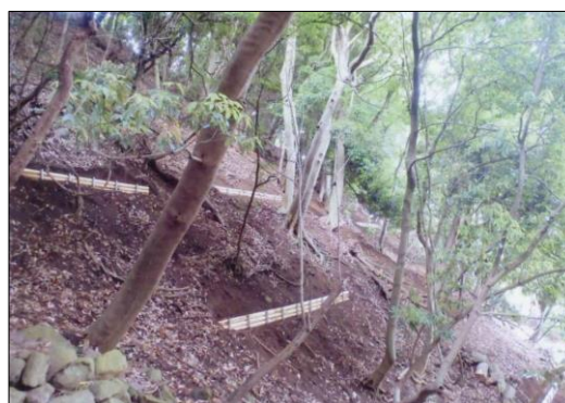
丸太筋設置 整備後
