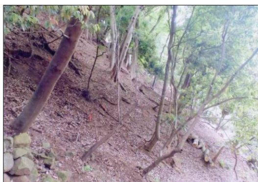
丸太筋設置 整備前
