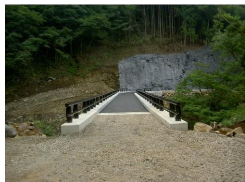
(宮城野橋施工後)
