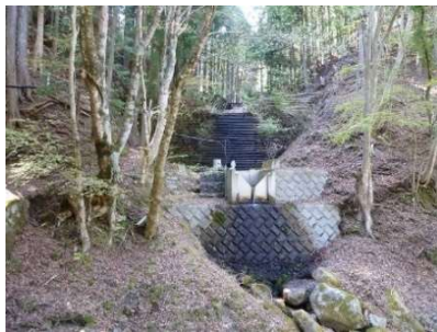
写真3 流量を観測する施設（山北町ヌタノ沢）
