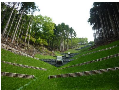
浅瀬治山工事（山北町世附地内）
