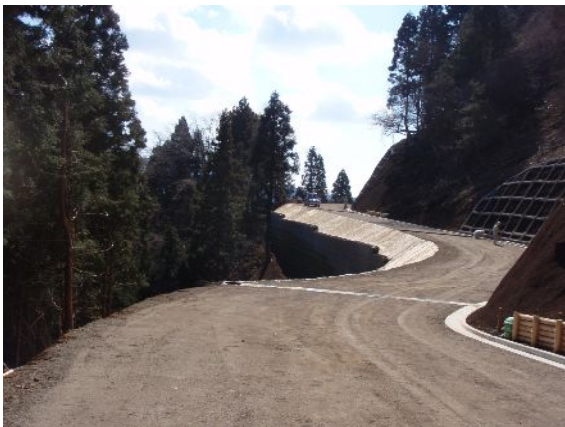
八丁神縄林道開設工事 [熊山工区] (山北町皆瀬川地内)
