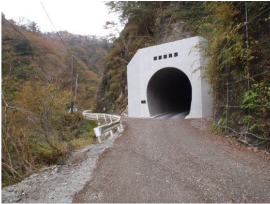
玄倉林道改良工事 [2号隧道付替] (山北町玄倉地内)
