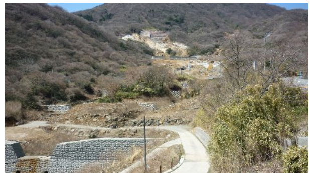
蛇骨沢上流治山工事（箱根町元箱根地内）
