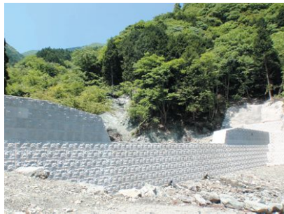
（平成21年度日蔭沢下流治山工事）
