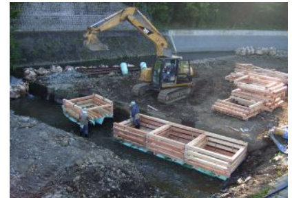
木工沈床の河川工事
