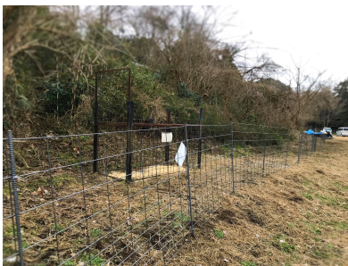
△平成30年度に設置した鉄柵
