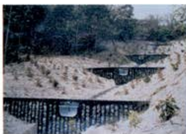
復旧工事完了時
