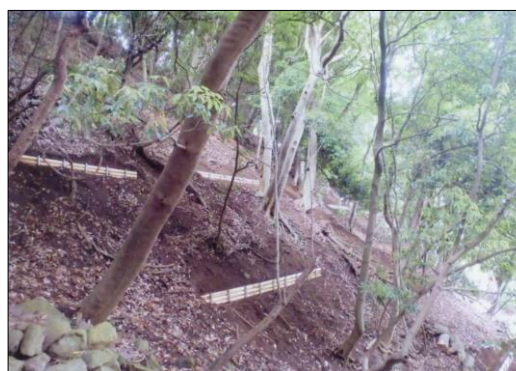
丸太筋設置 整備後
