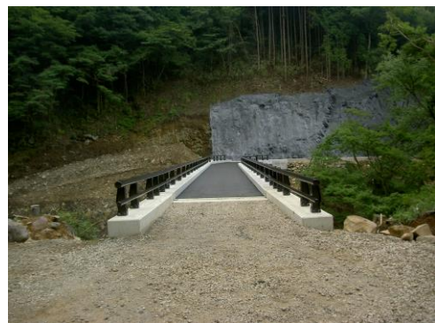
(宮城野橋施工後)
