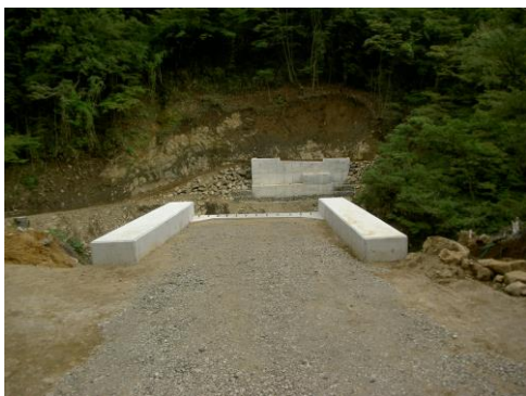
箱根町 宮城野 (宮城野橋施工前)
