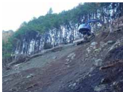
山北町世附地内 (世附川右岸4治山工事の法面整形にロッククライミングマシン(バックホウ)導入の様子)
