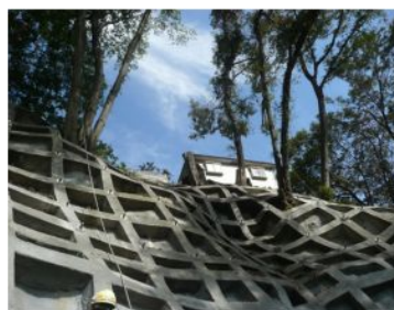
法枠工（施工後）
