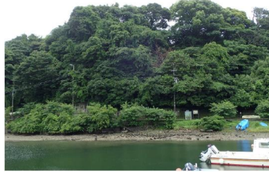
▲山腹崩壊危険地区の例
