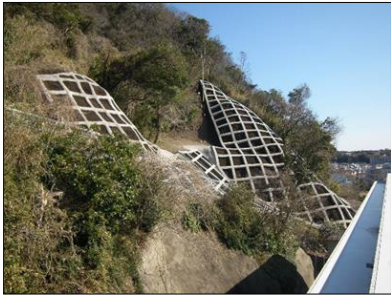
立石川治山工事
