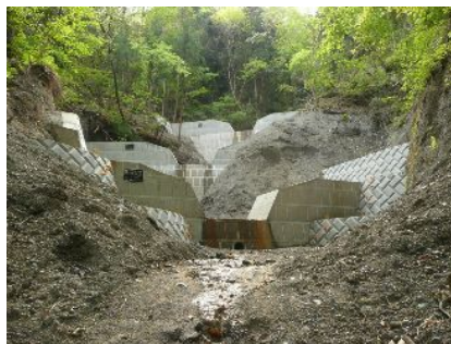
千戸沢治山工事
