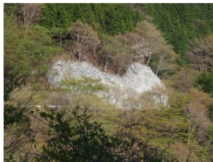
薬師林道改良工事
