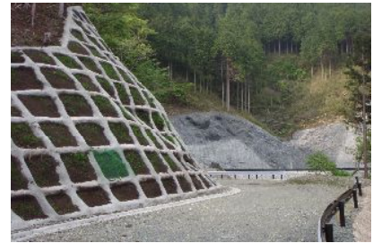
八丁神縄林道（八丁工区）
