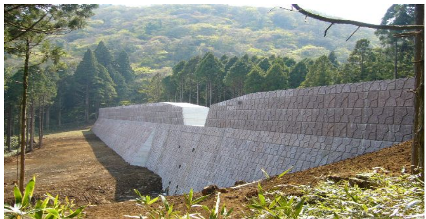
蛇骨川上流治山対策 土石流対応型スーパー治山堰堤
