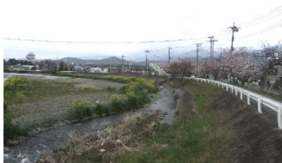
上流から見た御所堤
