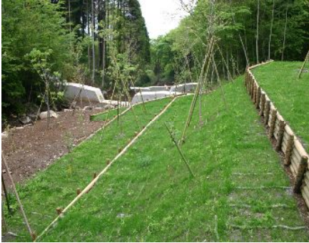
生分解性植生シート施工
